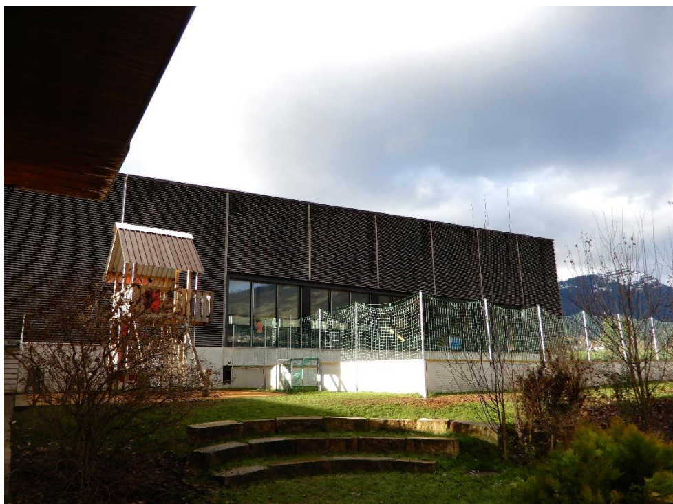
Die Mehrzweckhalle „Husmatt“ in Lauerz – der Tagungsort 2023
